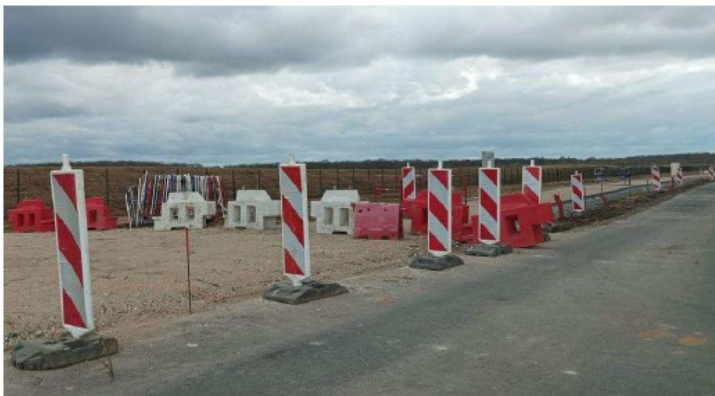
Travaux de voiries – route forestière fermée
