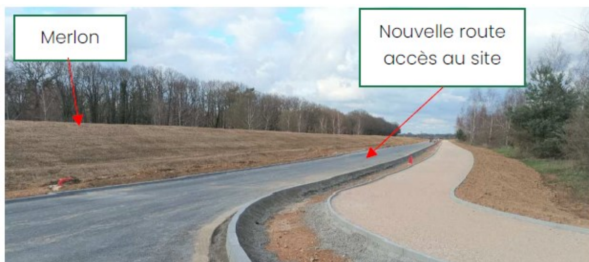
Travaux de voiries – route forestière fermée
