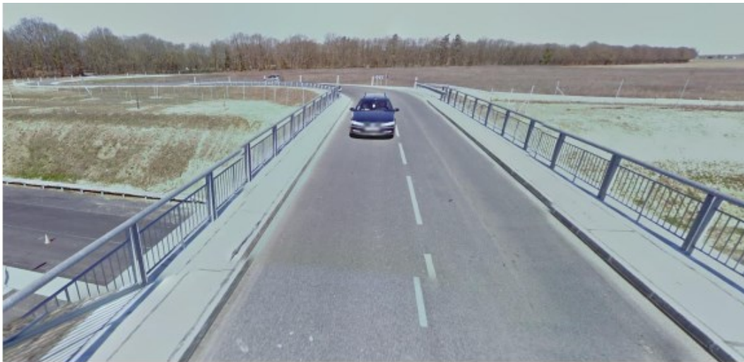
Franchissement de l'A19 le long de la route forestière
